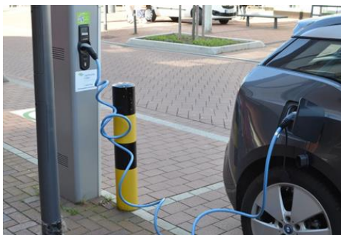
Abb. 4.6-1 E-Ladesäule während des Ladevorgangs 15
